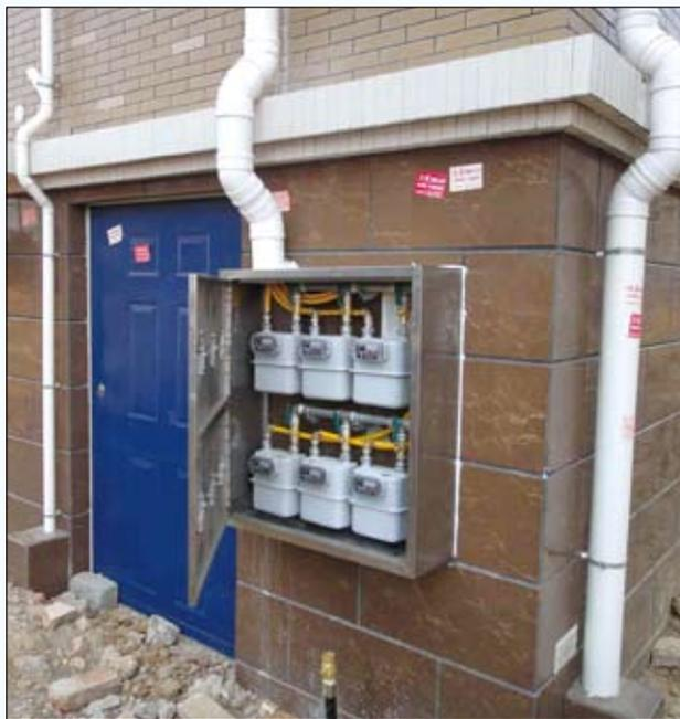
图1 新建小区采用户外表箱集中挂表方式
