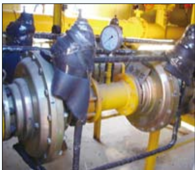
图6 使用带加热的调压器指挥器
