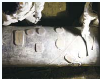
图16 对腐蚀管线进行修复
