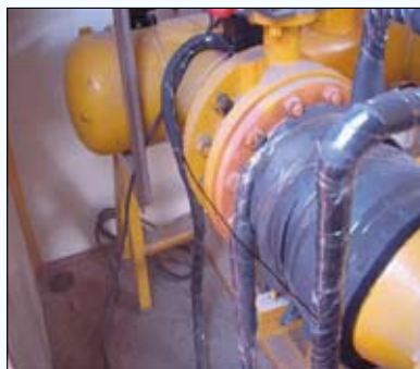
图5 对调压器系统缠绕伴热带
