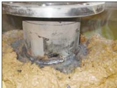
图1 焊接过程的降温措施
