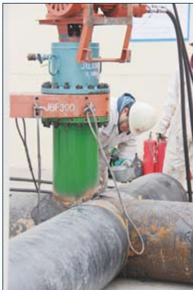
图2 焊接质量监控
