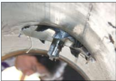
图3 翻转内衬修复后管道开孔
