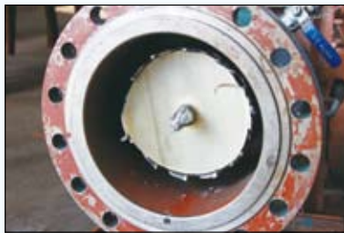
图4 翻转内衬修复后管道带压开孔的管道切片
