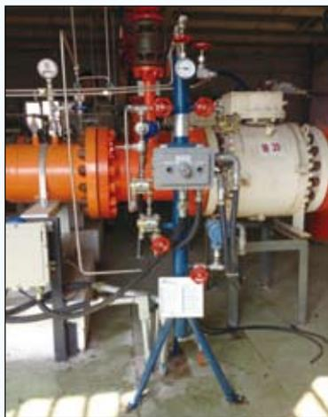
图2 LC-21调压装置装置实景图
