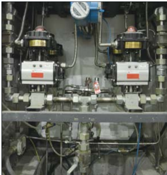
图1 加气柱内的阻力件
