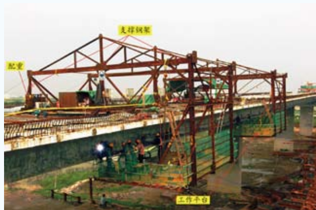
图4 移动式施工操作平台现场施工现场
