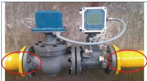
图2 流量计安装及设计不合理
