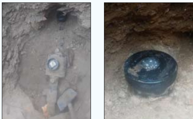
图7 阀门附近发现鞍型三通漏气
