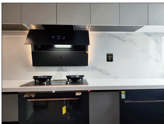
图8 燃气灶前燃气管道暗埋美装实景图
