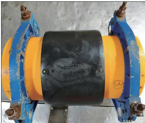
(a) 电熔接头安装焊接
